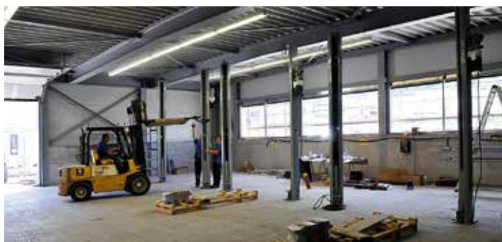
Die Autolifte werden eingebaut: Bevor das Karosserie-Lack-Center den Betrieb aufnimmt, dient es als provisorische Werkstatt.
