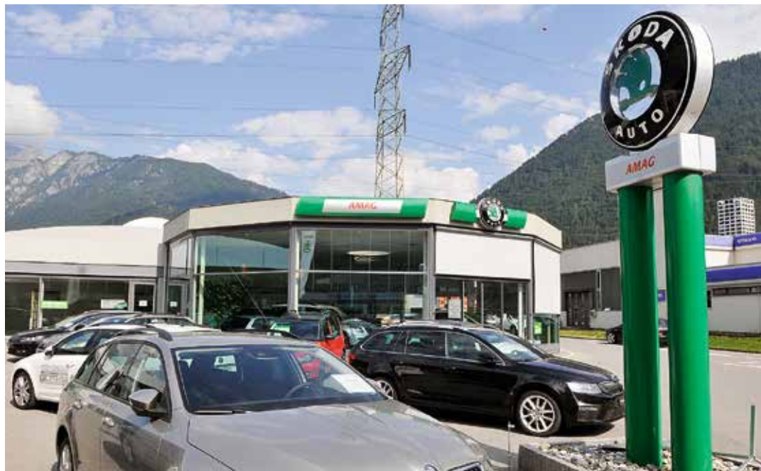
Die letzte Etappe: Der bestehende Škoda-Showroom wird abgerissen und durch einen Neubau ersetzt.
