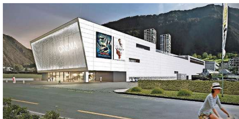
Baustart im Frühling: Das Grosskino soll im Herbst 2018 eröffnet werden.
