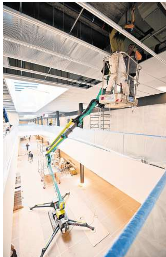
Hämmern, boren, fluchen: In der Mall des Einkaufszentrums City West muss noch überall Hand angelegt werden.
